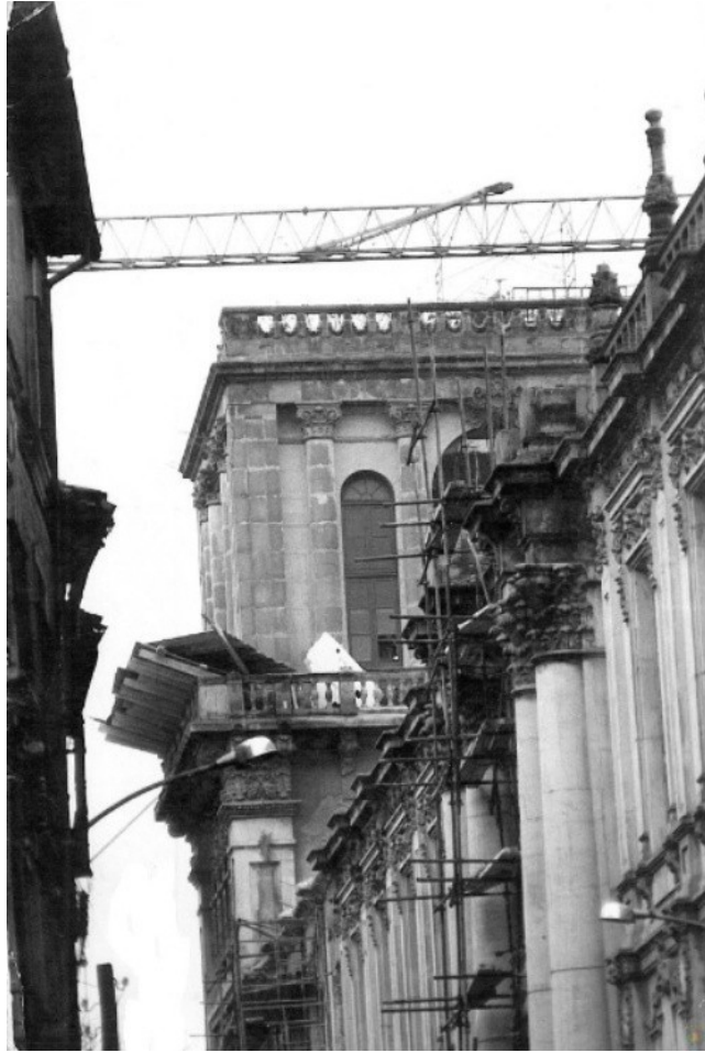
Derribo de la torre y fachada de la Universidad, 1968-1969
